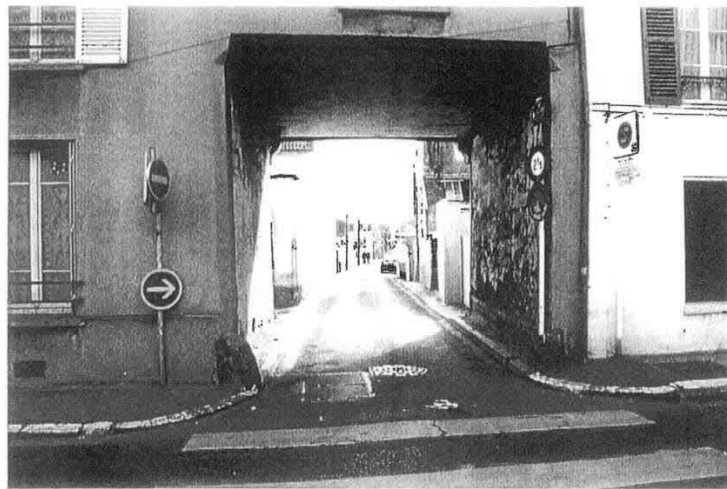
UN PORCHE TRANSFORME EN VOIRIE
