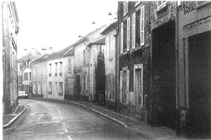
BEL EXEMPLE D'ALIGNEMENT DE FACADES ET DE DECROCHEMENTS DE TOITURES RUE DE L'EGLISE.
