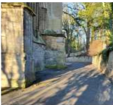
5- Vue sur le flanc Nord de l'église, mur de soutènement du cimetière
