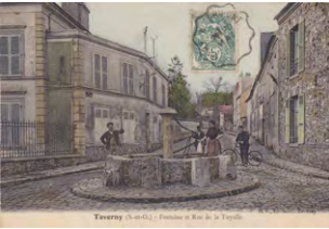
Fontaine, rue de la Tuyolle
