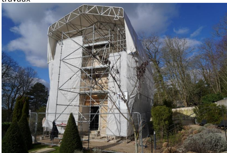
Chapelle Rohan-Chabot pendant les travaux
