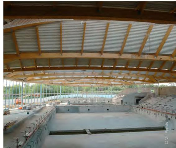
Les ossatures pour les parois du bassin olympique ont été posées, le bassin en inox sera installé dans les prochaines semaines. L'étanchéité avec le complexe sur la charpente est en cours de finalisation, tout comme le carrelage et la faïence dans les vestiaires.
