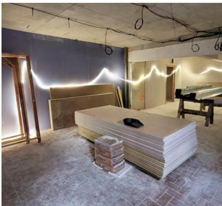
L'ancien local associatif du quartier des Sarments accueillera prochainement la micro-crèche. Les cloisons, le réseau de ventilation et le réseau de distribution électrique sont terminés. Les sols dans les locaux sanitaires sont en cours de finition ainsi que la structure totale des faux plafonds. De même pour les enduits et peintures.
